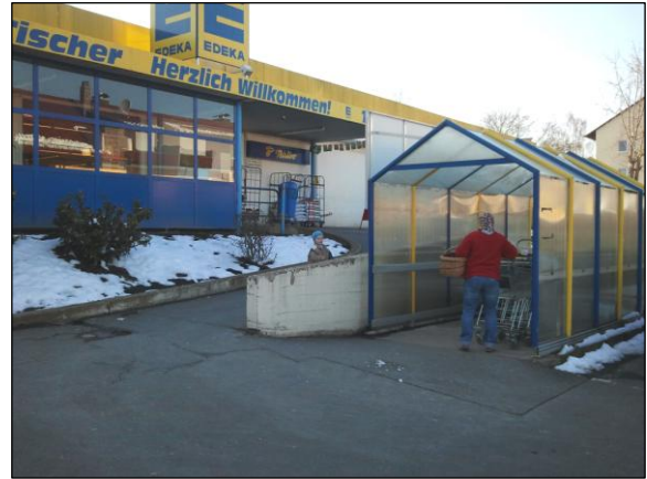
Bild 3: Eingangsbereich auf der Ostseite des Lebensmittelmarktes – Zugang über Fußgängerrampe
