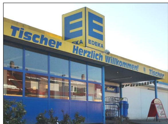
Bild 8: Bestehender Eingangsbereich auf der Ostseite
