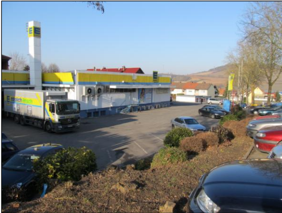
Bild 2: Südlicher Teil des Planbereichs / Lebensmittelmarktes mit Blick in Richtung Nordosten - Ladezone
