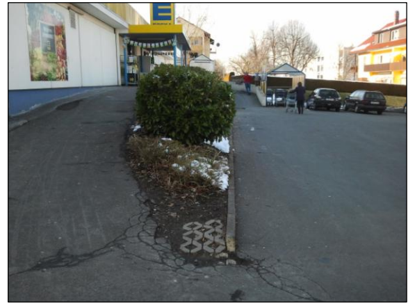
Bild 12: Grünstreifen östlich des Lebensmittelmarktes im Bereich des vorhandenen Zugangs
